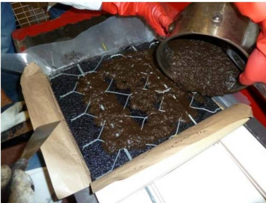
Figuur D: Aanbrengen slemlaag (bemerkt: 2 proefstukken stalen wapeningsnet aangebracht)
