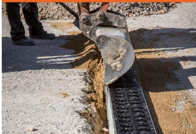
Plaatsing van een I-type roostergoot
